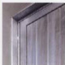
PARTICOLARE DELLA PANTANA DI RINFORZO TELAIO
