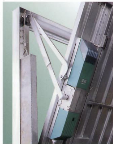
PARTICOLARE DEL MOTORE ELETTROMECCANICO
